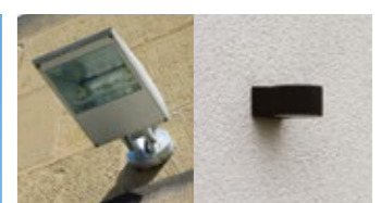
Optimale Hausbeleuchtung, bei der das Licht nur von oben nach unten abgestrahlt wird.
